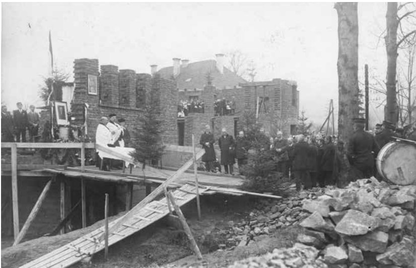
Gottesdienst auf der Baustelle des Evangelischen Jugendhauses „Prażakówka“. Ustron, 1930er Jahre.
