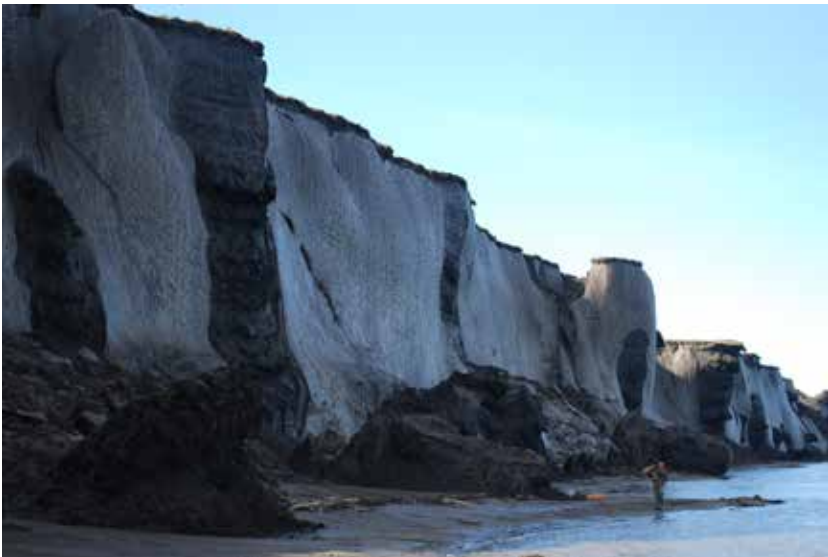
Abb.5: Seitlicher Blick auf das eisreiche Sobo-Sise-Yedomo-Kliff mit abgebrochenen Blöcken, das sich ca. 1,5 km am Strand der Lena entlangzieht. An seiner höchsten Stelle fällt das Kliff mit Permafrostboden 27 Meter steil ab – so hoch wie ein mehrstöckiges Haus. Person als Maßstab. Foto: Thomas Opel/AWI.
